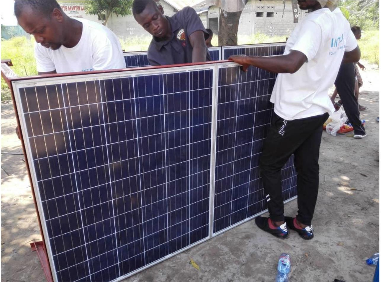
32. Nous avons installé une centrale solaire pour alimenter la pompe submersible d'une capacité de pompage de 2000 litres d'eau en une heure à une hauteur de 10 mètres, une hauteur qui dépasse celle de notre réservoir placé à 6 m de haut.
