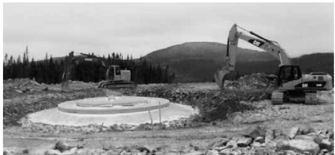
Fondation d'une base complétée et prête à recevoir une tour et finalisation des travaux de remplissage. (Photo : Germain Tremblay)
