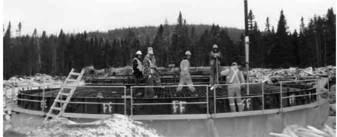
Construction d'une fondation destinée à accueillir une éolienne. Chaque base a 17 mètres de diamètres et 3 mètres d'épaisseur, ce qui a nécessité une cinquantaine de camions de ciment et 35 tonnes d'acier. La hauteur des tours variera de 63 à 98 mètres. (Photo : Germain Tremblay)
