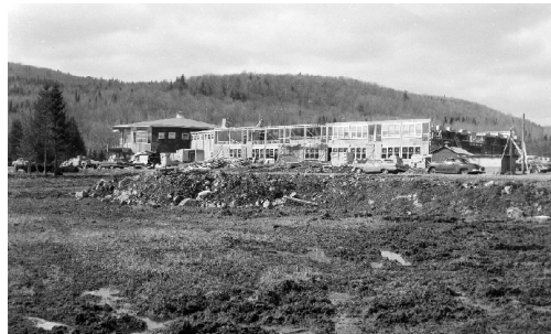
Le Manoir du Lac Delage en cours de construction Parue dans la revue d'architecture Bâtiment , vol. 39, no. 5, mai 1964, p. 39
