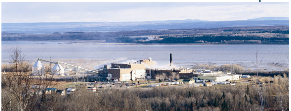
Photo de l'ancienne usine AbitibiBowater
